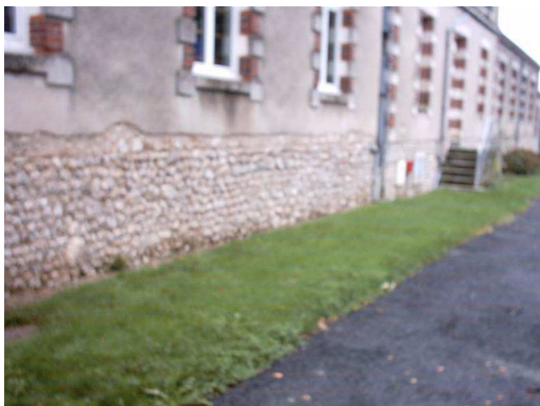
Dégarnissage des enduits pendant asséchement
