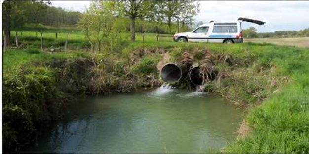
Affouillement en amont d'un ouvrage
