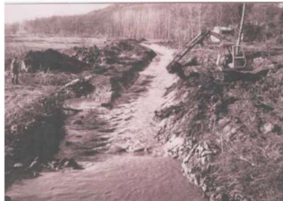
Photo datant de 1966 de rectification et recalibrage de la Nizonne
