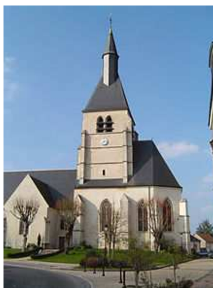
Eglise de PIERRE FITTE SUR SAULDRE
